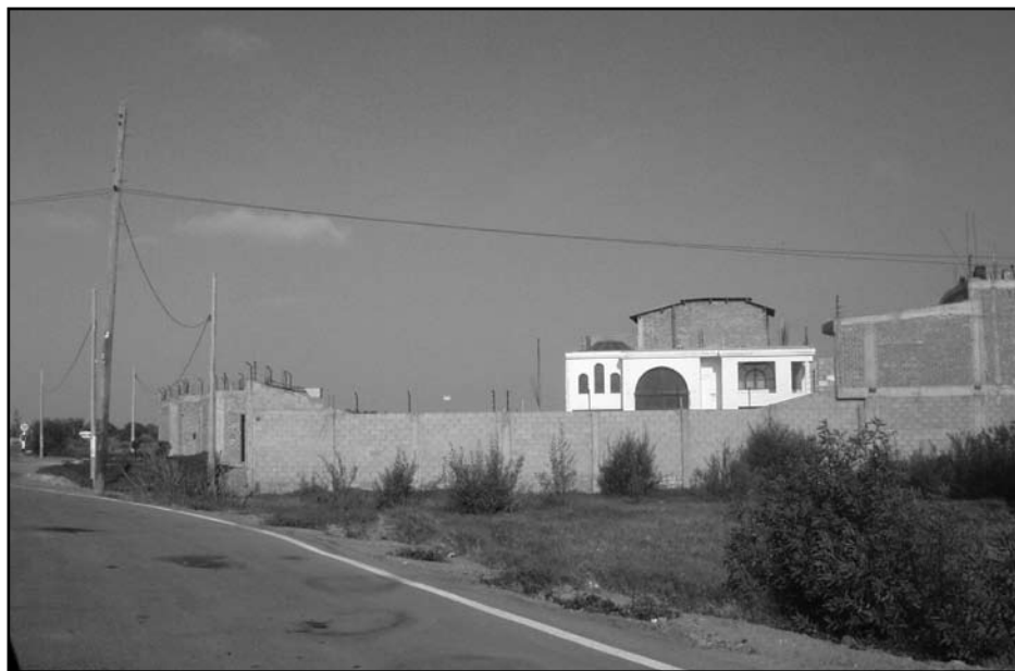
Construcción de grandes residencias y departamentos de Mi Vivienda en el Eje Chiclayo-Pimentel © Omar Pereyra
